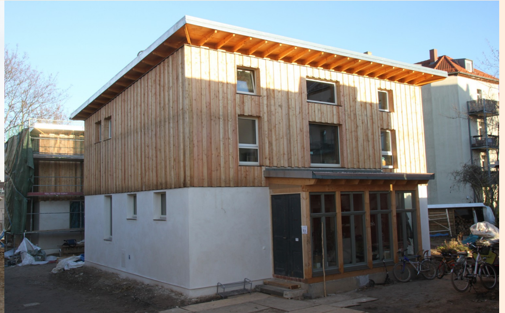
Das fertige Strohballenhaus mit Putz und Holzschalung
